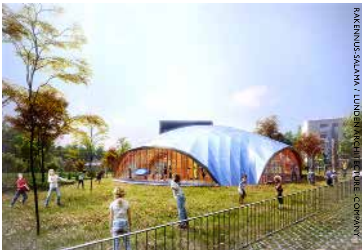
Turkuun valmistuva päiväkotiperustuu puukuorirakenteeseen, jolla voidaan tehdä monimutkaisia rakenteita suorista puusauvoista.
